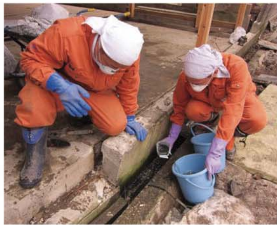
側溝の清掃に汗を流す
