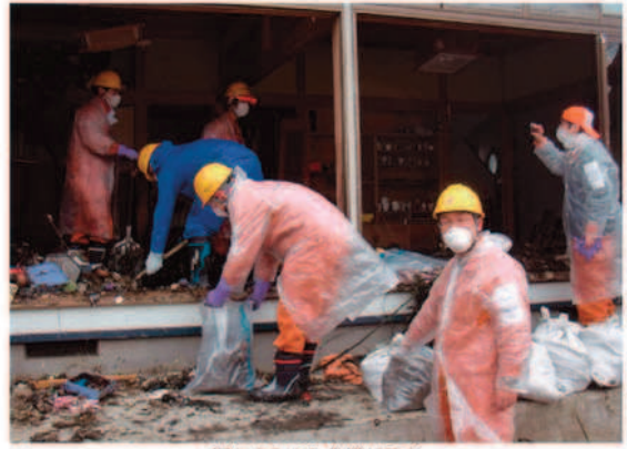
泥にまみれた作業が続く
