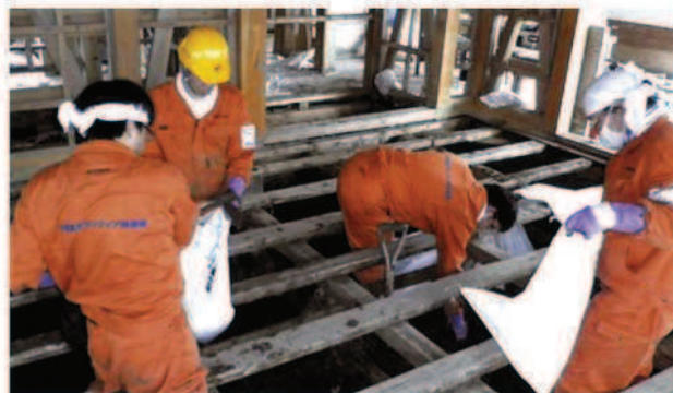
中部支部第2陣。民家の床下に積もった泥を排除するのに汗びっしょり
