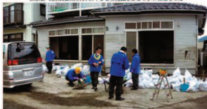
東京都・関東支部第3陣。床下からの泥出しはきつい作業となった
