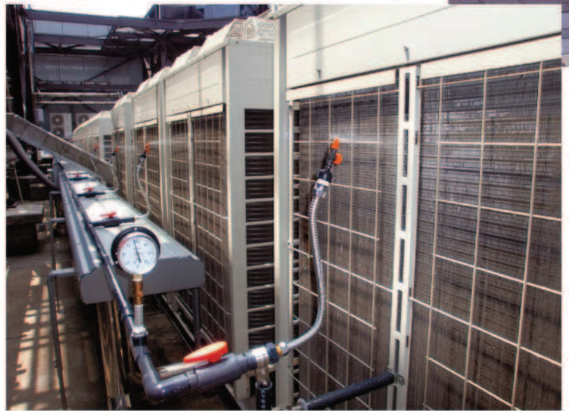
エアコン室外機への噴霧散布 (写真提供: 東和産業)
