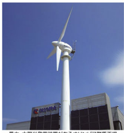
風力・太陽光発電装置があるオリンピア群馬工場
