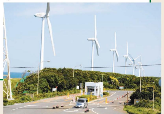
鹿島港沖の洋上風力発電所。環境省等の支援も受け、事業は順風だ▶
