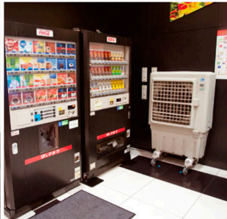
ホールの隅々に送風機。自動販売機は消灯中
